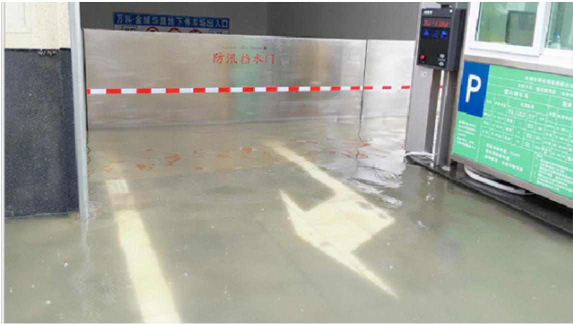
防洪门可分为:组合式挡水门、密闭式挡水门、液压式挡水门一、适用范围:产品广泛应用于地下室、车库、地铁、仓库等地方,防洪门对水灾起到很好的防护作用。二、产品特色:1、特制的防水密封条,具有抗老化、耐高、低温性能,具有良好的弹性和抗压缩变形性,在-50度-120度区间都可以维持其高密封性能。防洪门密封条与地面完全贴合,能有效的阻止水的渗入。2、防洪门安装在特制的紧密框架中,拆装方便快捷。3、防洪门内部较强度骨架,面板经过防腐处理,坚硬、美观。防水板贴有黄黑相间的反光条,可在灯光或其他光源的照射下反射光线,起到对人员的警示作用,方便人员进出,夜间容易辨别,防止人员被绊倒。
