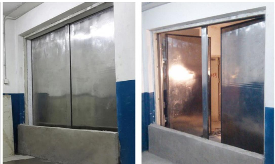
防汛防洪专门用的型挡水门历经强台风和水灾检验，防汛实际效果非常理想化，我们这一薄厚的商品在铺面应用就可以考虑应用规定了，我生产厂家能够依据应用地区不一样生产制造不一样薄厚的挡水板。挡水板，又被称为防水板，防汛板，防洪门等。挡水板规格一般全是依据当场精确测量订制，并沒有固定不动的规格。我生产厂家一般会把挡水板规格设定一个规范，即铝合金型材材料的挡水板，大部分一层的高宽比是20厘米高宽比，能够累加。限制由于生产厂家不一样能够做到1.6米-2.0米的高宽比。金属材质挡水板规格，基本高宽比为40-60厘米，限制高宽比一般在2.0米长。
